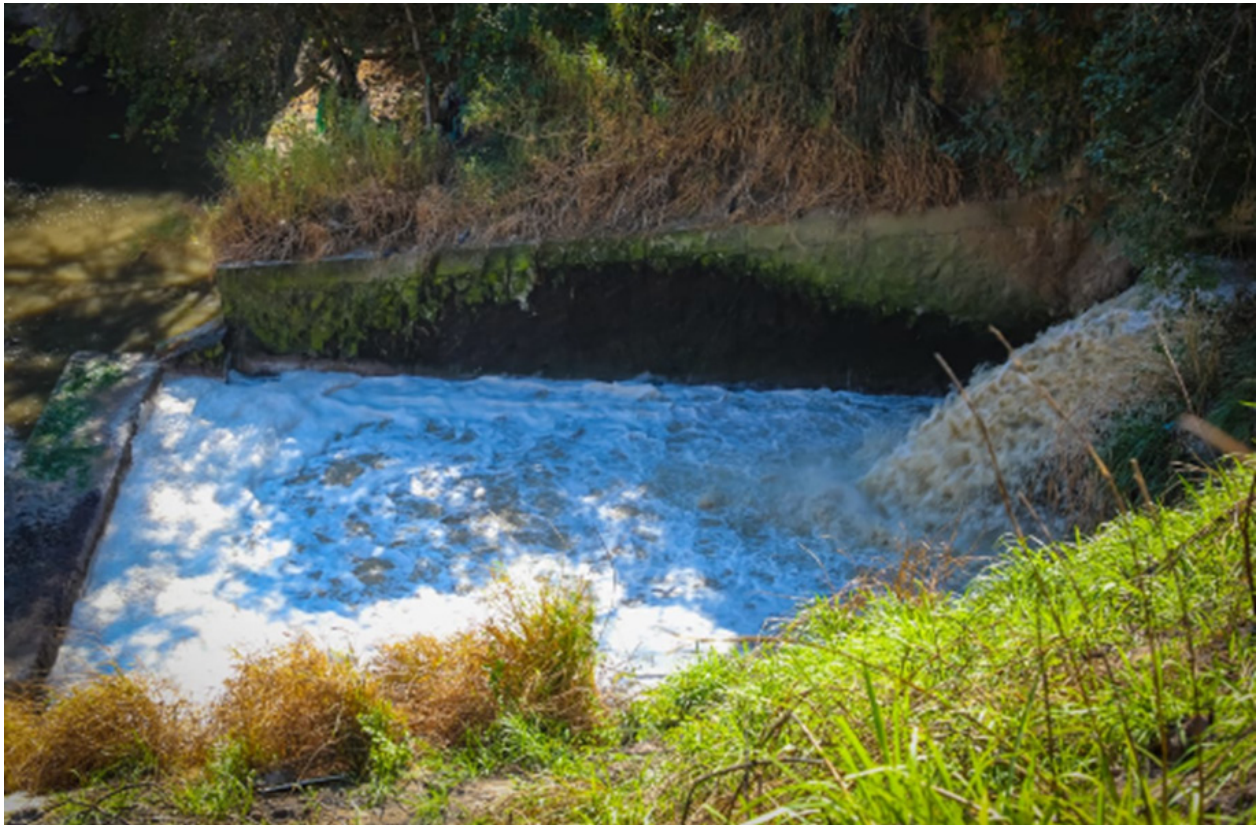
Figura 3. Vista del sitio donde se descarga actualmente las aguas residuales.
