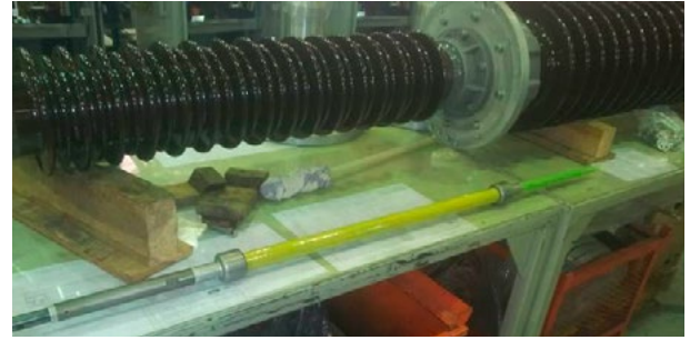
Biela interna de accionamiento
