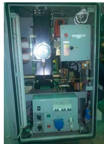
Mecanismo de accionamiento a resortes
