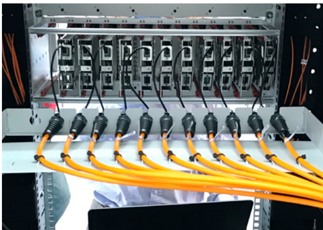
Figura 3. Acceso Jumpers de bahía en ODF.
