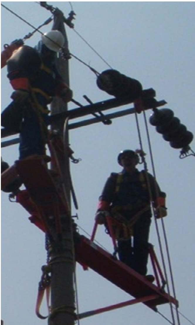
Plataforma para trabajos en estructuras tipo Bandera.
