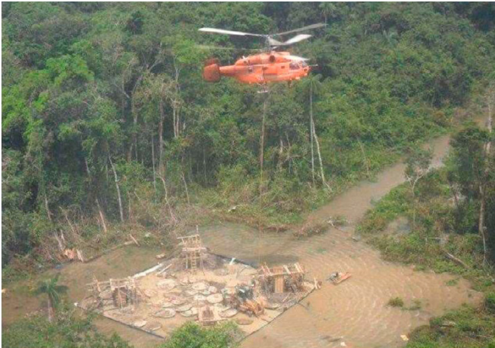
Figura 3. Helicóptero transportando equipamentos, materiais e máquinas.
