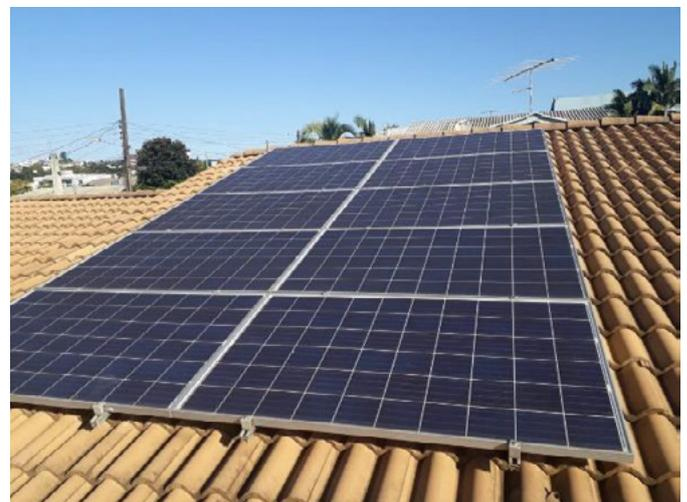
Figura 6. 10 módulos de 265W para cada instalação.
